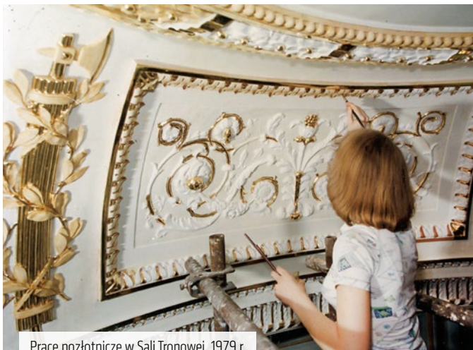
Prace pozłotnicze w Sali Tronowej, 1979 r.
